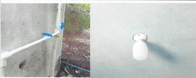
FOTO 5: CAMBIO DE TUBERIA DE AGUA. CAMBIO TOTAL DE CABLE Y DUCTO ELÉCTRICO, COLOCACIÓN DE BOMBILLAS, APAGADORES Y TOMACORRIENTES
