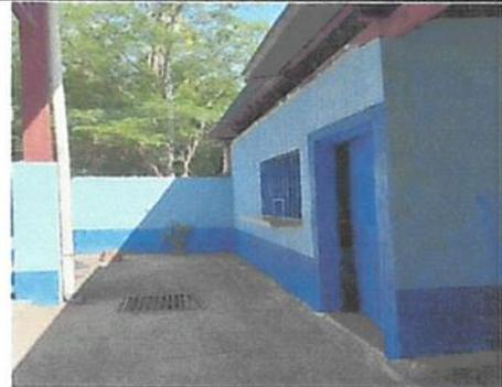
FOTO 4: LEVANTADO, REPELLO , CERNIDO Y PINTURA DE PARED DE COCINA
